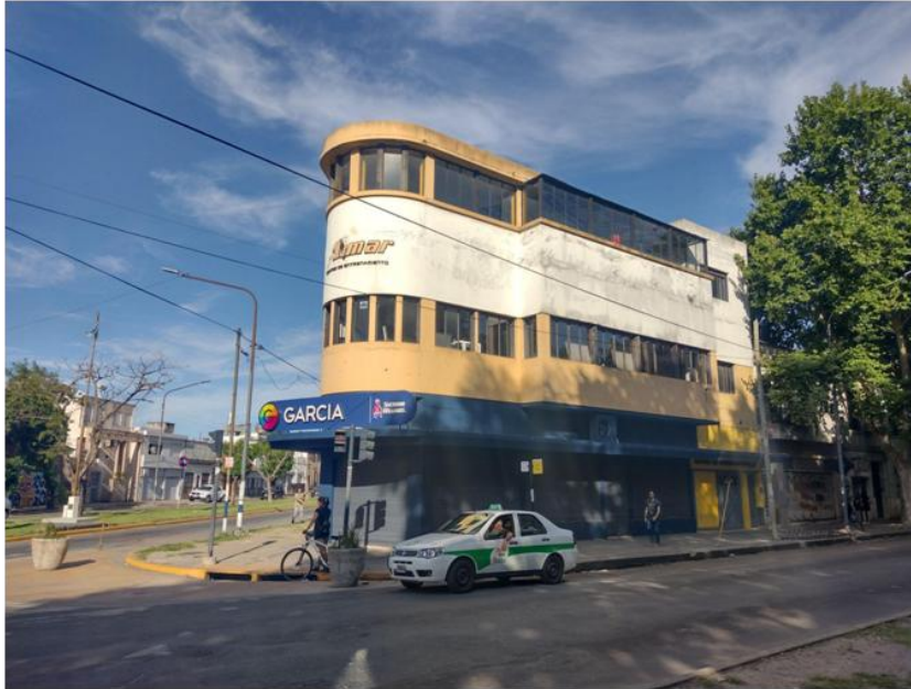
Esquina de 1 y 60 en la actualidad, donde en el segundo piso funcionaba el teatro del Bosque. (Foto: Victoria Balaguer)
