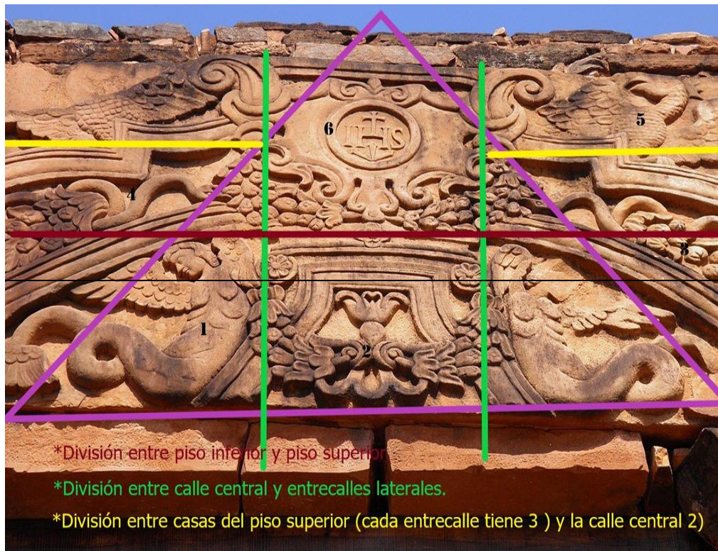
Fig.2. Detalle de Fig.1. Segmentación del portal a fines de analizarlo según método Panofsky y posible conformación de fachada-retablo. Recuperado de: Magadán, M. (2009). Trabajos de conservación en un sitio de patrimonio mundial: La misión jesuítica-guaraní de San Ignacio Miní).
